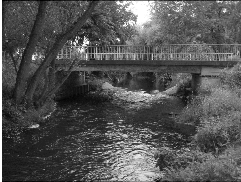
Bild 3: Beidseitig sind Kiesdepots eingebracht, die die Seeve selbst verlagern soll
