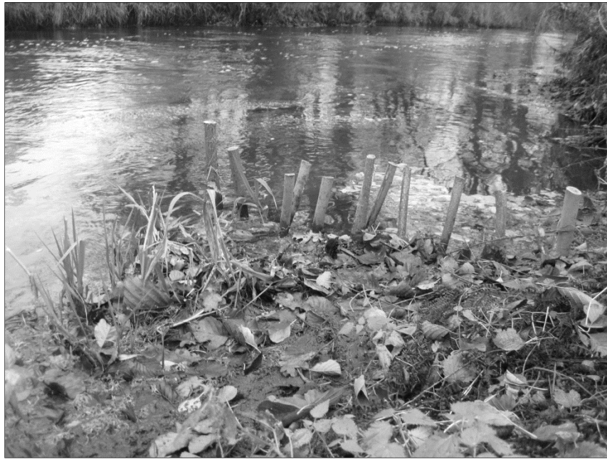
Bild 24: Nach Herstellen zweier Reihen „Hölzchen und Stöckchen“ zeigt sich die erwünschte Wirkung schnell – „Ufer“ entsteht neu
