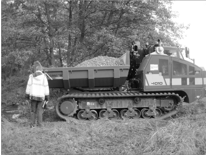
Bild 12: Mit Gummikette-bereiftem Dumper werden Kies und Geröll direkt ins Gewässer geschüttet
