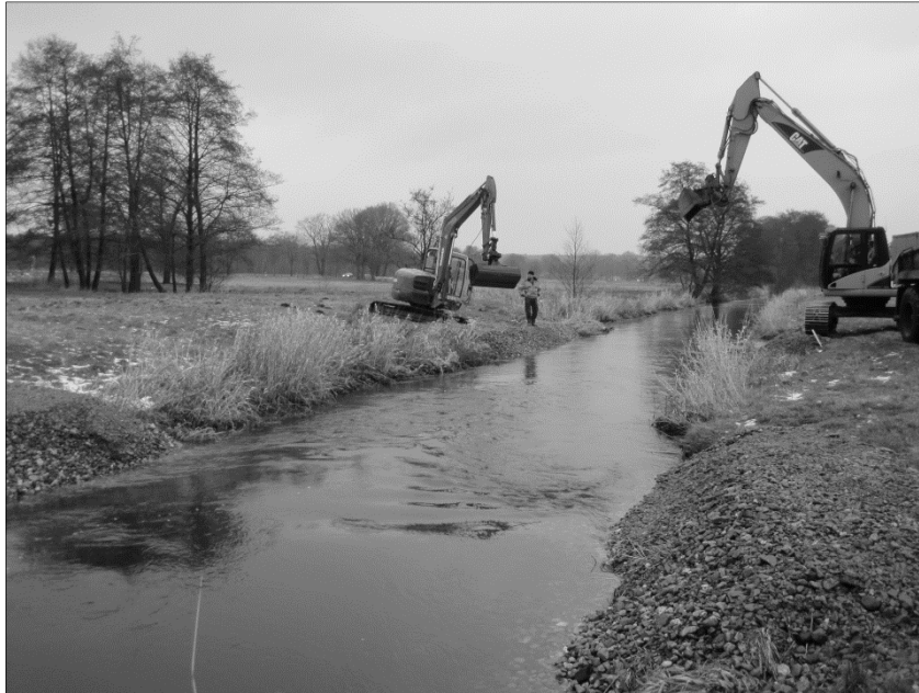
Bild 9: Seeve Wiedenhof, Lenkbuhnen- und Laichbettaufbau erfolgt mit Großgerät
