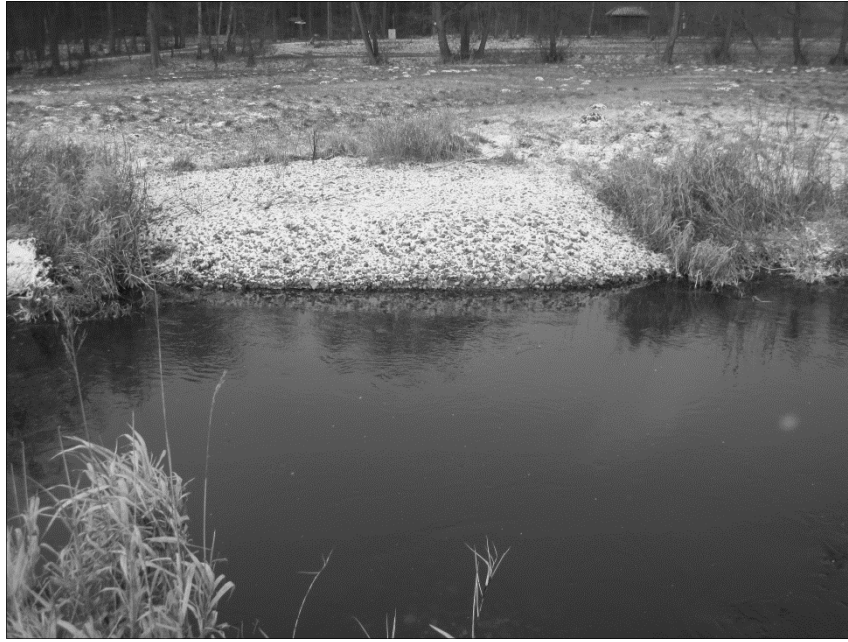
Bild 11: Eine Anzahl Kies-/Gerölldepots kann später mit Harken ins Gewässer eingebracht werden
