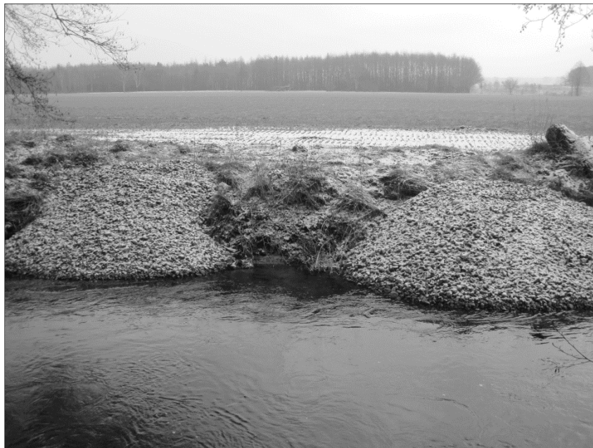
Bild 13: In intensiv genutzter Agrarlandschaft erhält das übertief eingeschnittene Gewässer Depot-artig geschüttetes Material für Ufer- und Sohlgestaltung durch Eigendynamik, ggf. ergänzt durch Handarbeit
