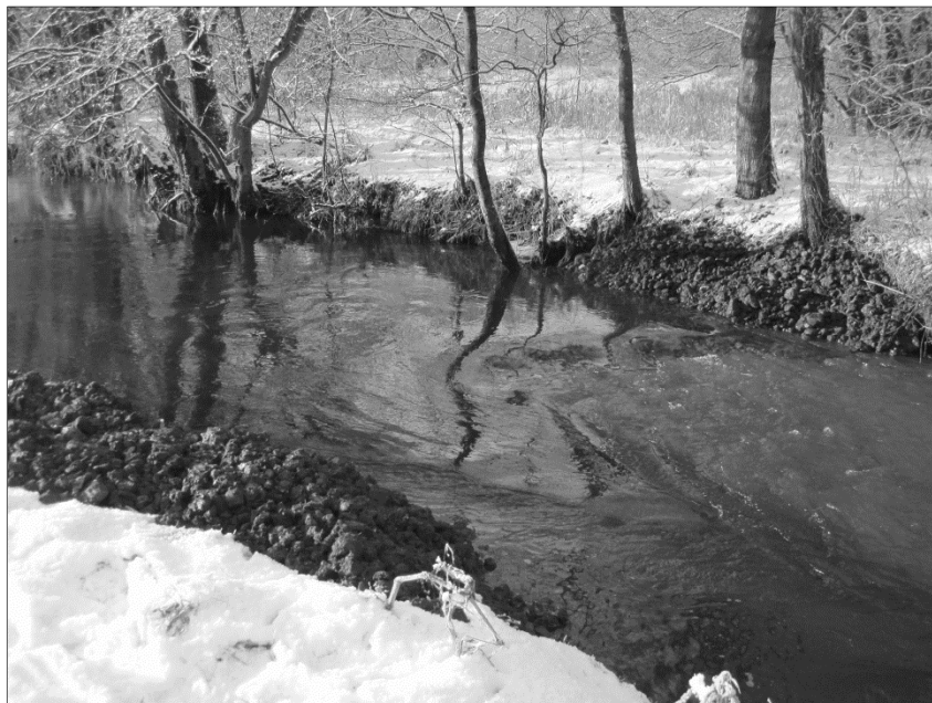
Bild 6: Beispiel einer Lenkbuhne mit beidseitigem Uferschutz
